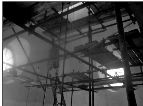
(фото справа). Старую, плохо держащуюся штукатурку сбили, стены пропитали антисептическими составами, нанесли новый силикатный раствор и, на той же основе, грунт и шпаклевку. Так что, при благоприятном стечении обстоятельств, в скором времени можно будет начинать роспись.
